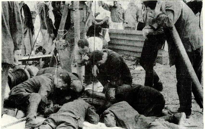
Atentos a las indicaciones de los bomberos que han descendido al pozo para rescatar a los infortunados obreros. (Foto Guillamón.)
