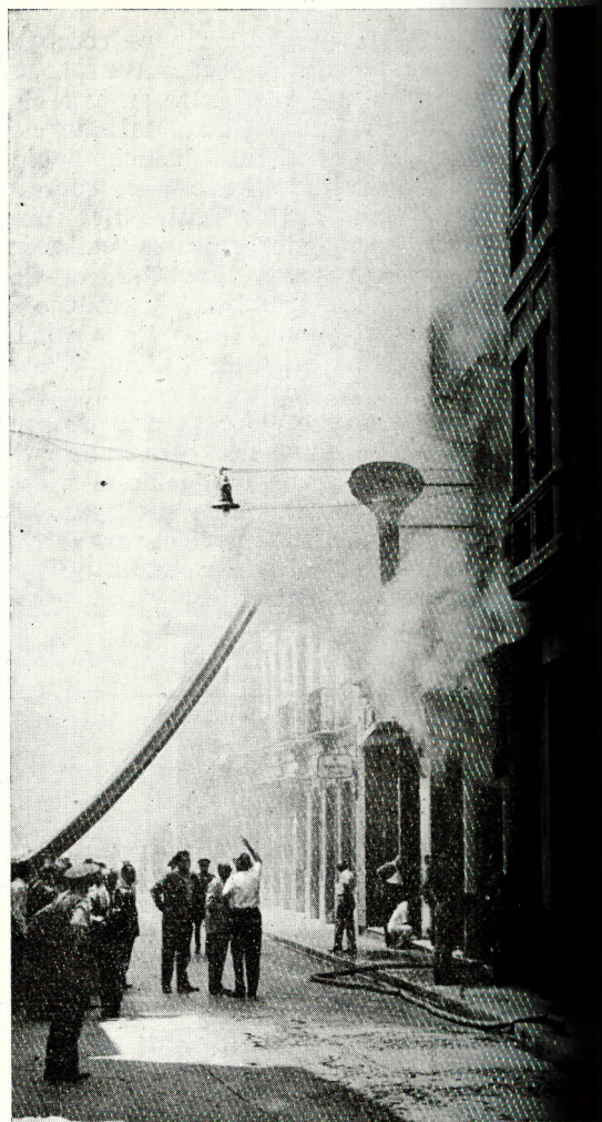
Después del fuego, con la manga salvavidas en el tercer piso
